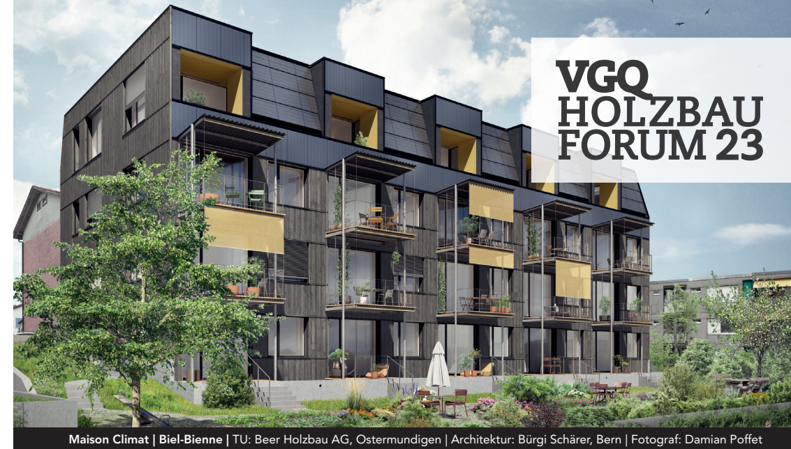
Maison Climat | Biel-Bienne | TU: Beer Holzbau AG, Ostermundigen | Architektur: Bürgi Schärer, Bern | Fotograf: Damian Poffet
