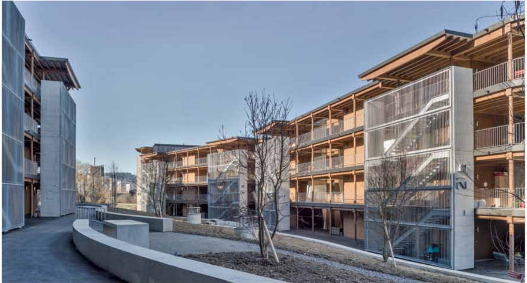
Zusammenhängender Binnenraum als Herz der Anlage, den Häusern vorgestellte Veranden schaffen Bezug zu gemeinsamem Raum
