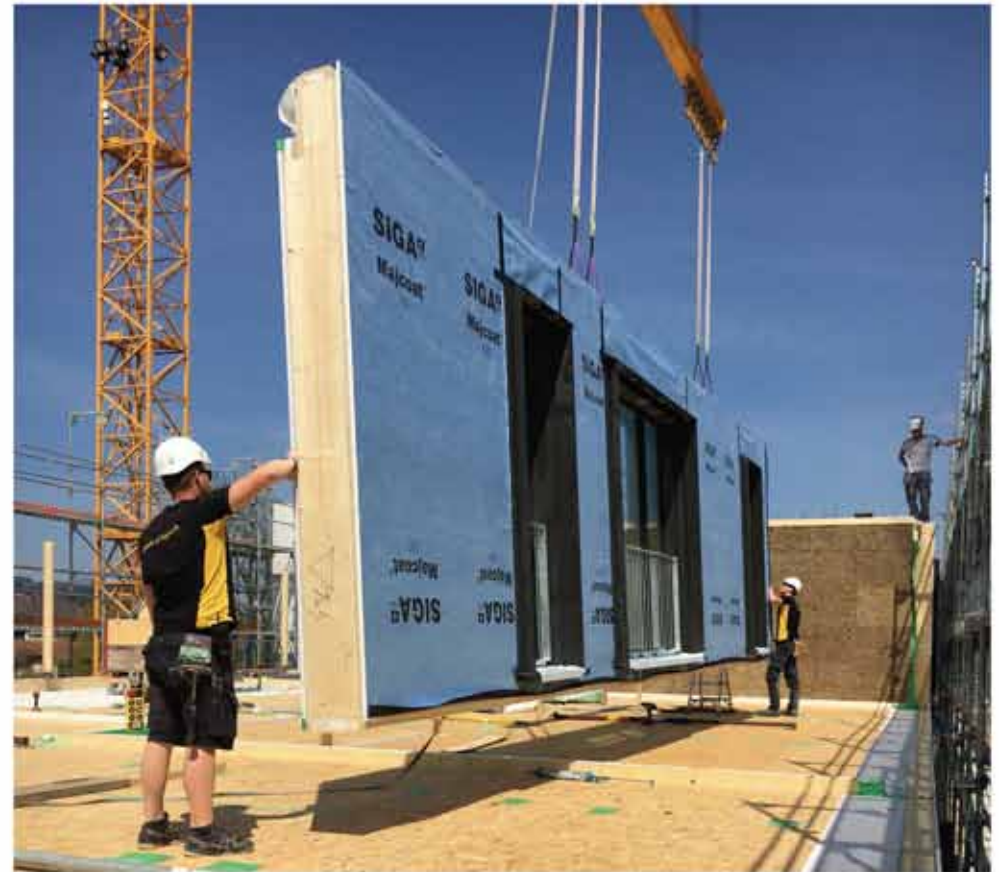
Denken in Elementbauweise; Zeiteinsparung dank Trockenbauweise (keine Spriessung der Decken, keine Austrocknung, keine Baufeuchte) und Halbfertigprodukte
