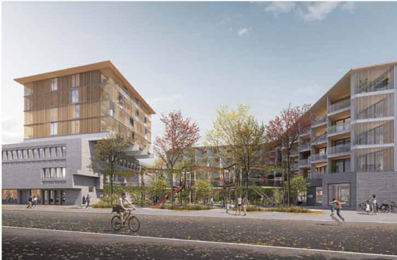
Urbane Nachverdichtung durch 4-geschossige Aufstockung in Holzbauweise und Ersatzneubau in Holz, Bauherrschaft: Planzer AG
