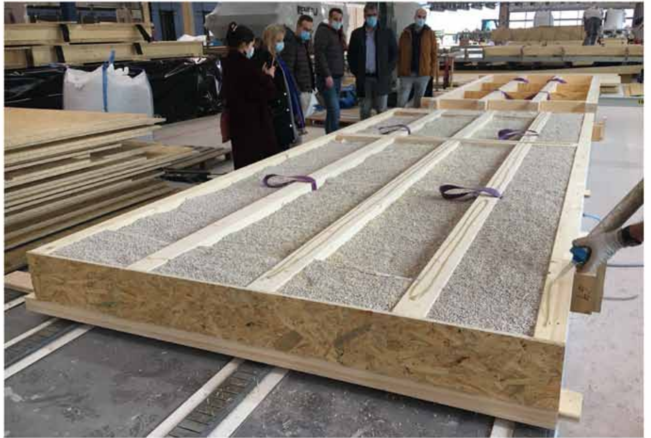
Denken in Holzbauweise: Vorfabrikation; Gleichzeitigkeit der Arbeiten und höhere Bauqualität dank idealen Bedingungen in der Werkstatt (Abbund Deckenelement in der Halle)
