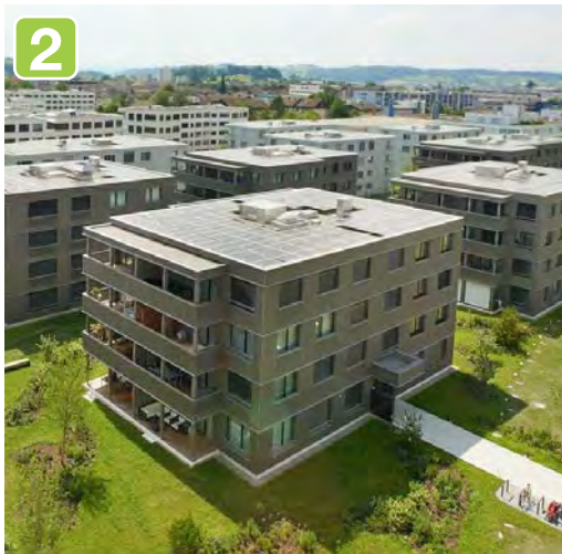
2 Suurstoffi 19-35 Holzbausiedlung Wohnen
