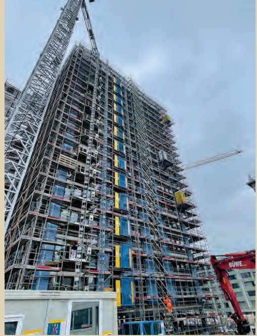
2024 Hochhaus BBI Papieri Areal Cham 50 Meter
