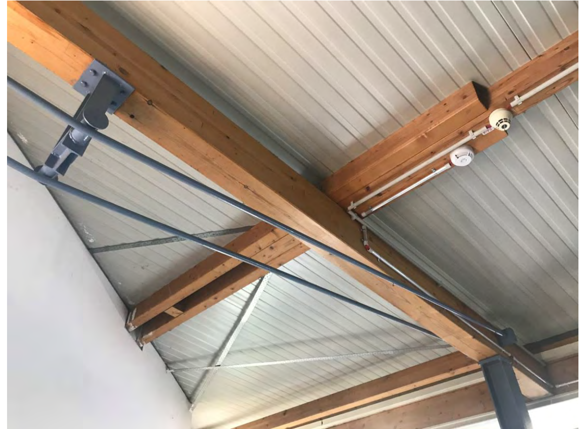
Dachträger, unterspannter Leimholzbinder
