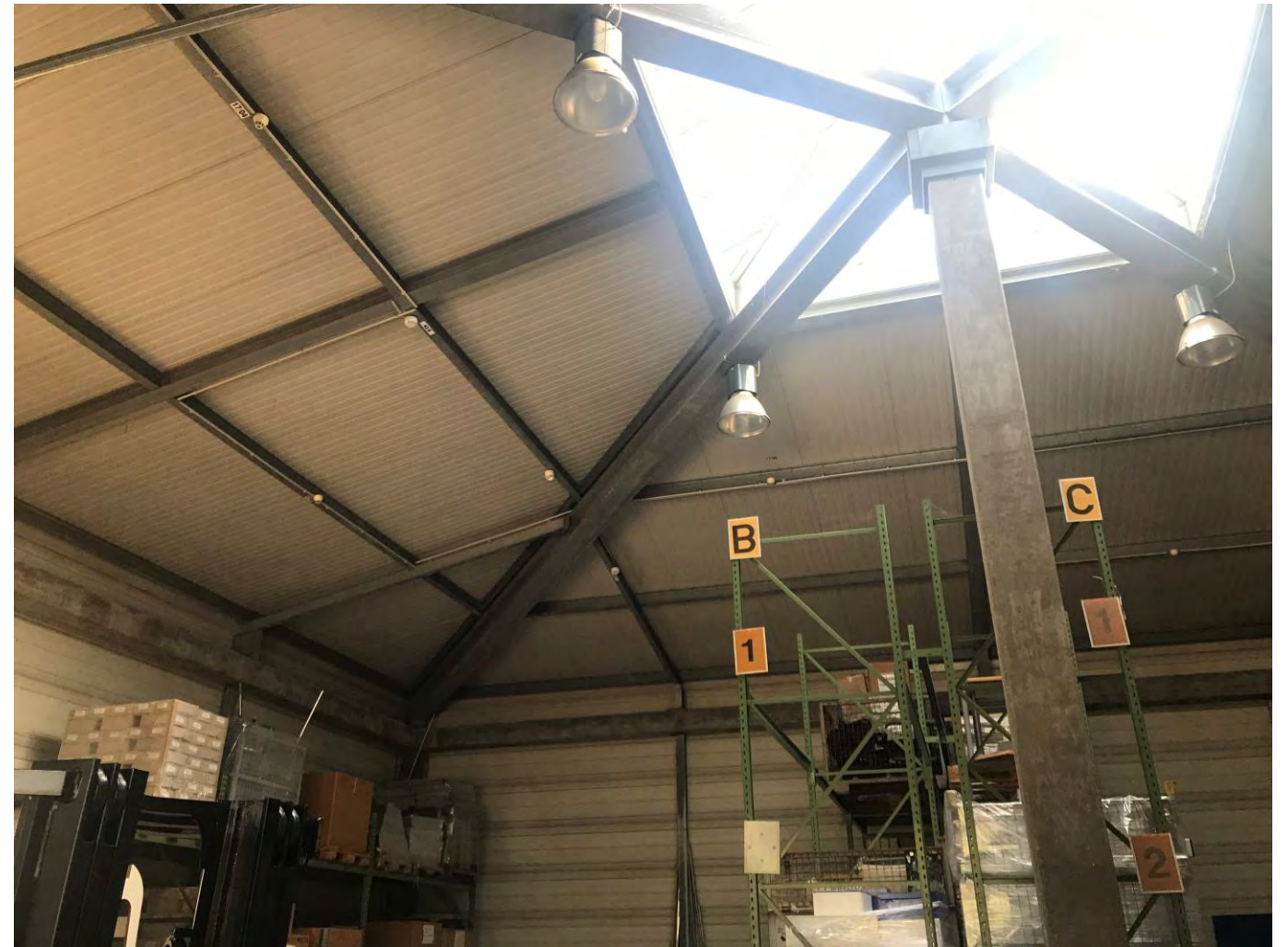
Lager, mit Haupttragwerk: eingespannte StB-Rahmen (Ortbeton), Stahl-Fassadenstützen und Dachträger (St37)
