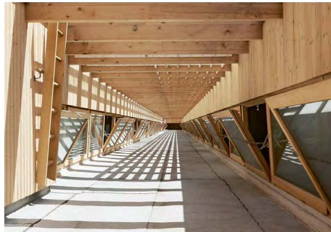
Schulzimmerlüftung und Pufferzone
