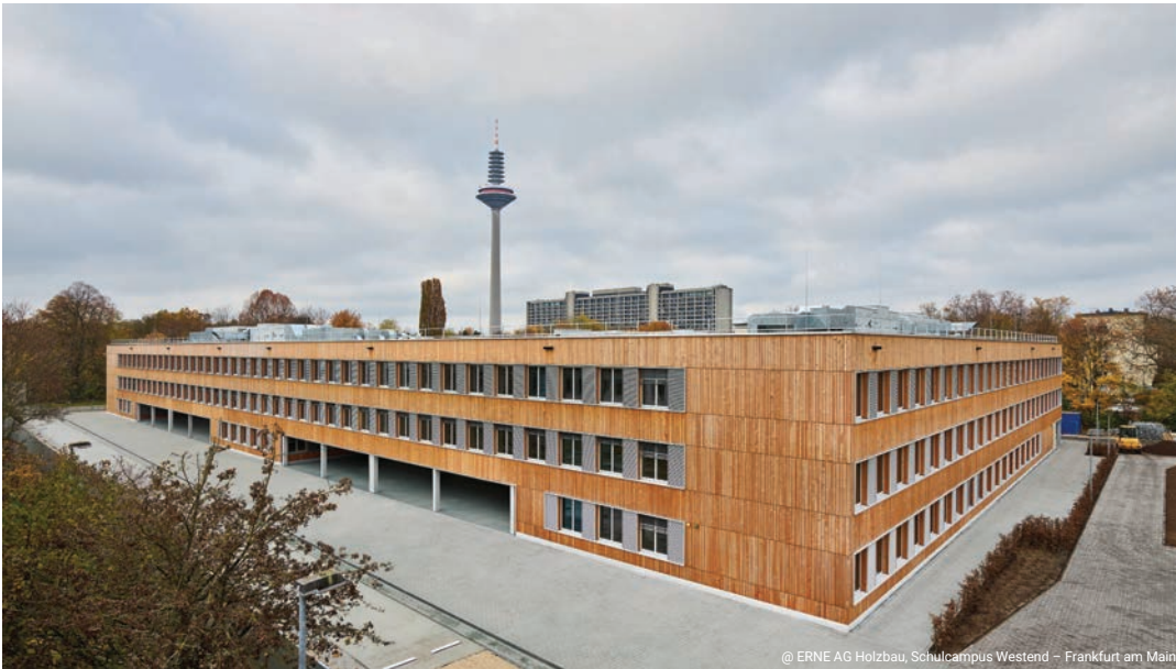
@ ERNE AG Holzbau, Schulcampus Westend - Frankfurt am Main
