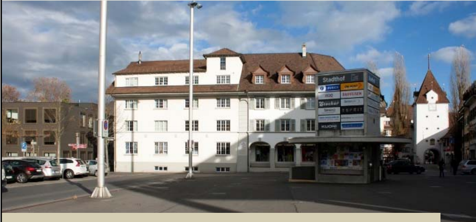
Renggli AG: Generalunternehmung, Holzsystembau, Engineering
