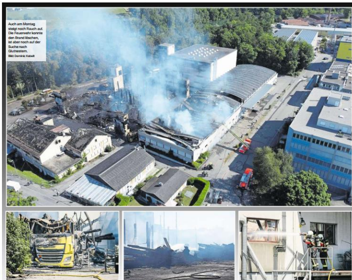
Der Schaden, den das Feuer in Spreitenbach angerichtet hat, ist riesig. Neben Gebäuden haben auch viele Fahrzeuge gebrannt.
