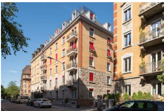
Sanierung MFH Rotachstrasse 22, Zürich Architekt: Linearch GmbH, Zürich Holzbau- und Brandschutzingenieur: Josef Kolb AG, Romanshorn
