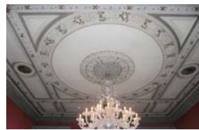
Erhaltenswerte Decken Bauliche Massnahmen kaum möglich (ev. von oben)
