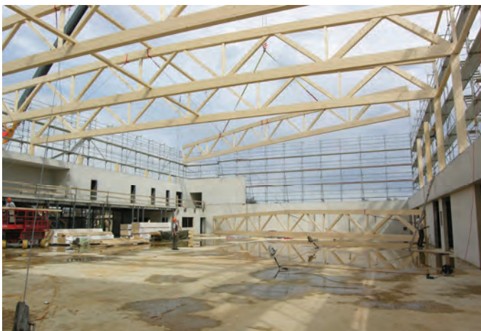
Sporthalle Erlen, Montage Holzfachwerke
